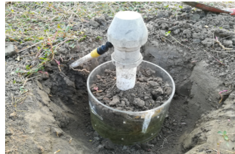
图5 亚克力材质圆桶安装情况
